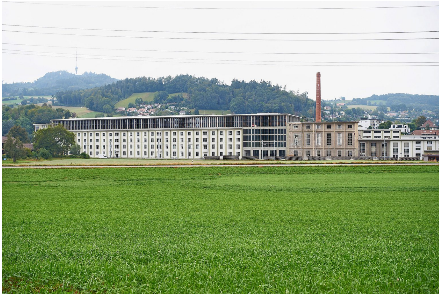
Im Bernapark sind auf dem Gebäude der alten Papierfabrik zwei Etagen Wohnungen aus Holz aufgebaut. Foto: Barbara Héritier
